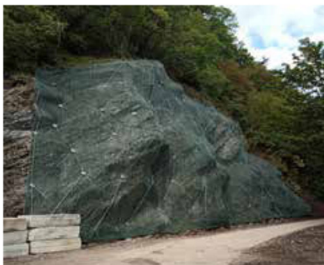
Rafforzamento completato con ArrFort Pet - Fopla di Solignano (PR)
