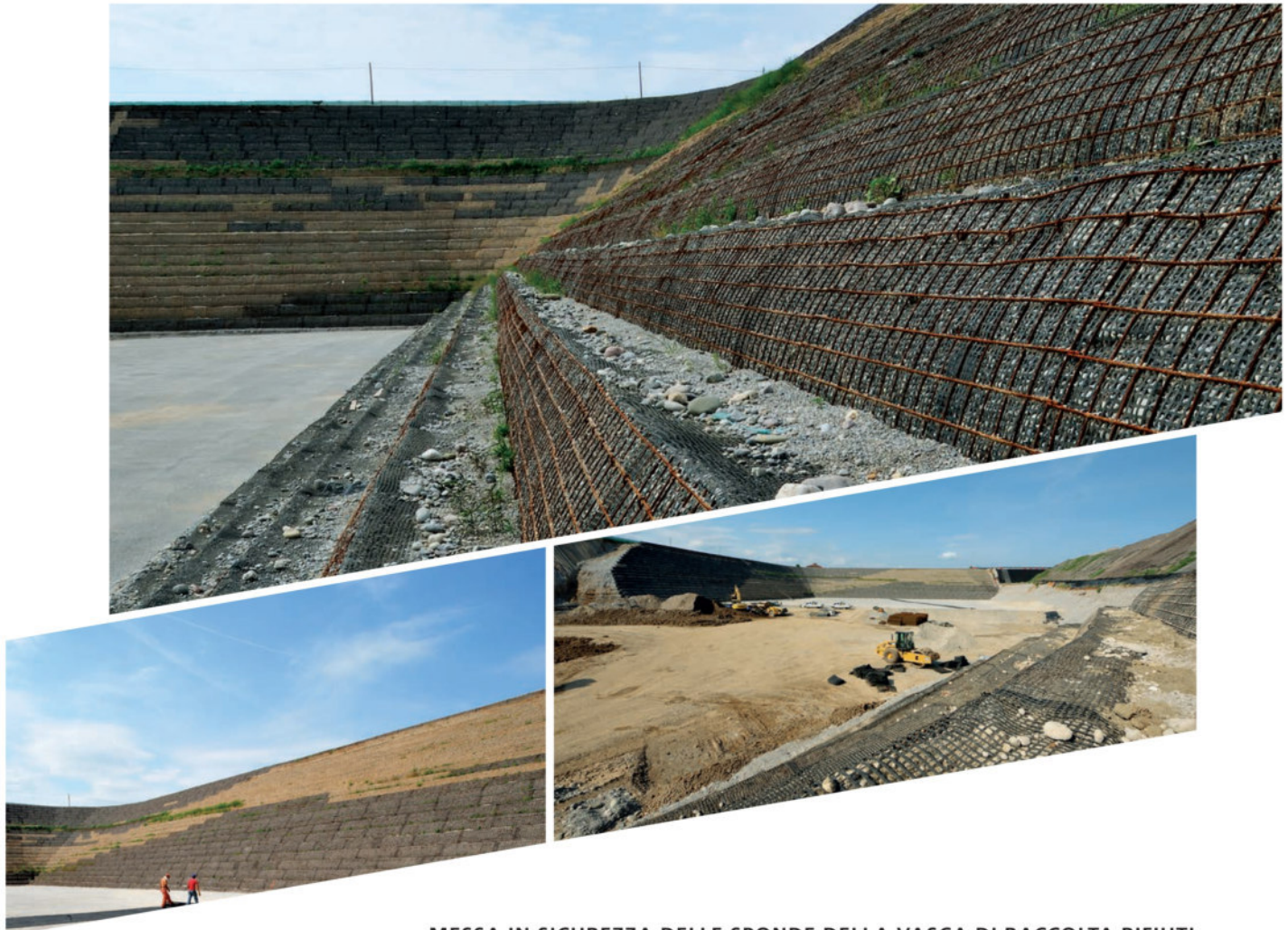
MESSA IN SICUREZZA DELLE SPONDE DELLA VASCA DI RACCOLTA RIFIUTI CON GEOGRIGLIE PAVIROCK
