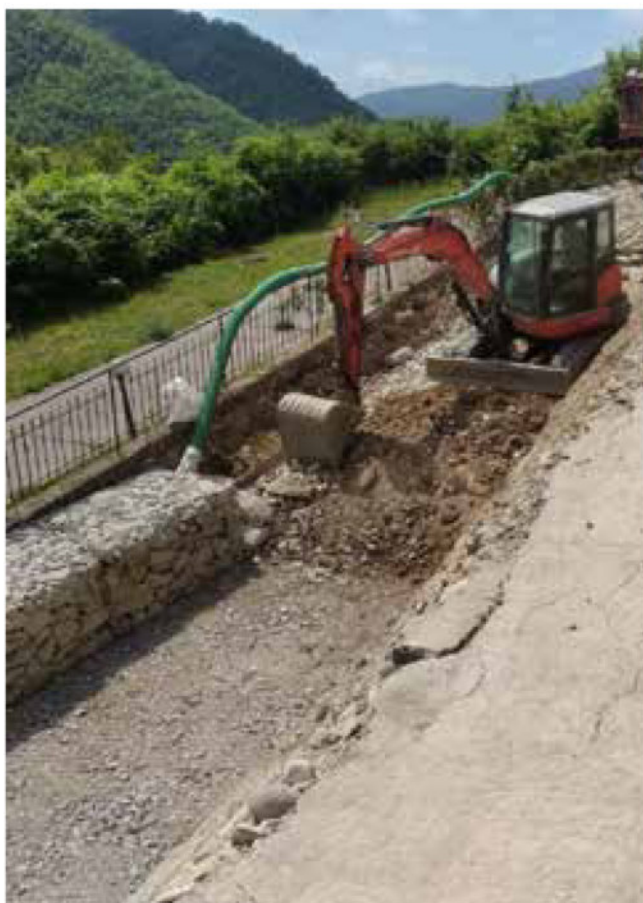
Sistema ArrSystem, consolidamento di sottoscampa stradale -Podenzana (MS)
