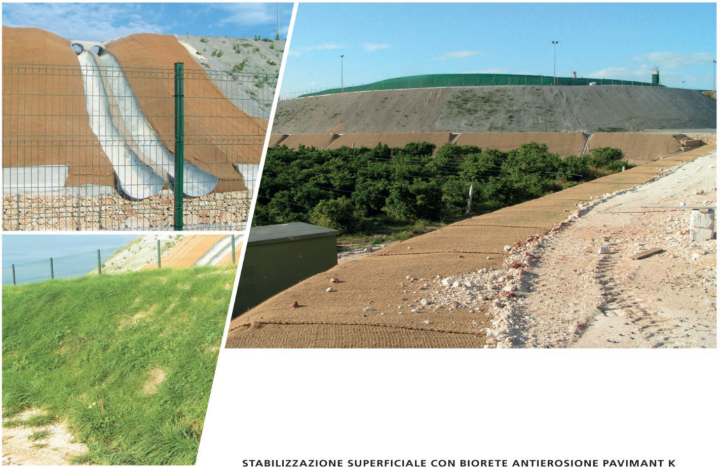
STABILIZZAZIONE SUPERFICIALE CON BIORETE ANTIEROSIONE PAVIMANT K
