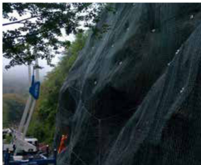
Fasi di posa geocomposito ArrFort Pet
