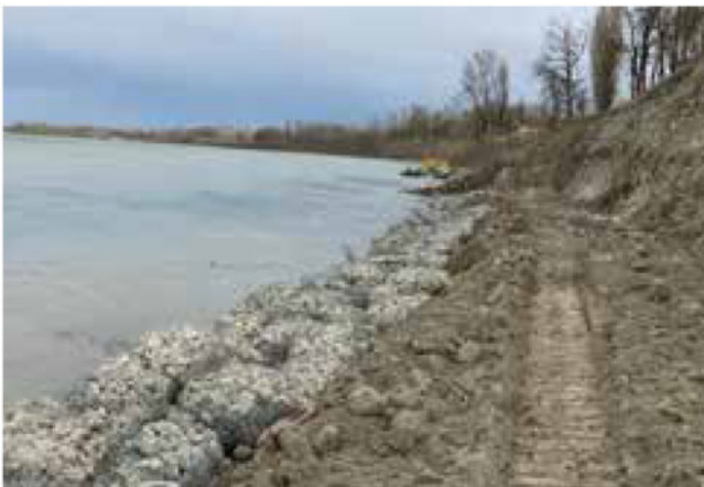
Difesa spondale in burghe - Fiume PO Torre d'Oglio
