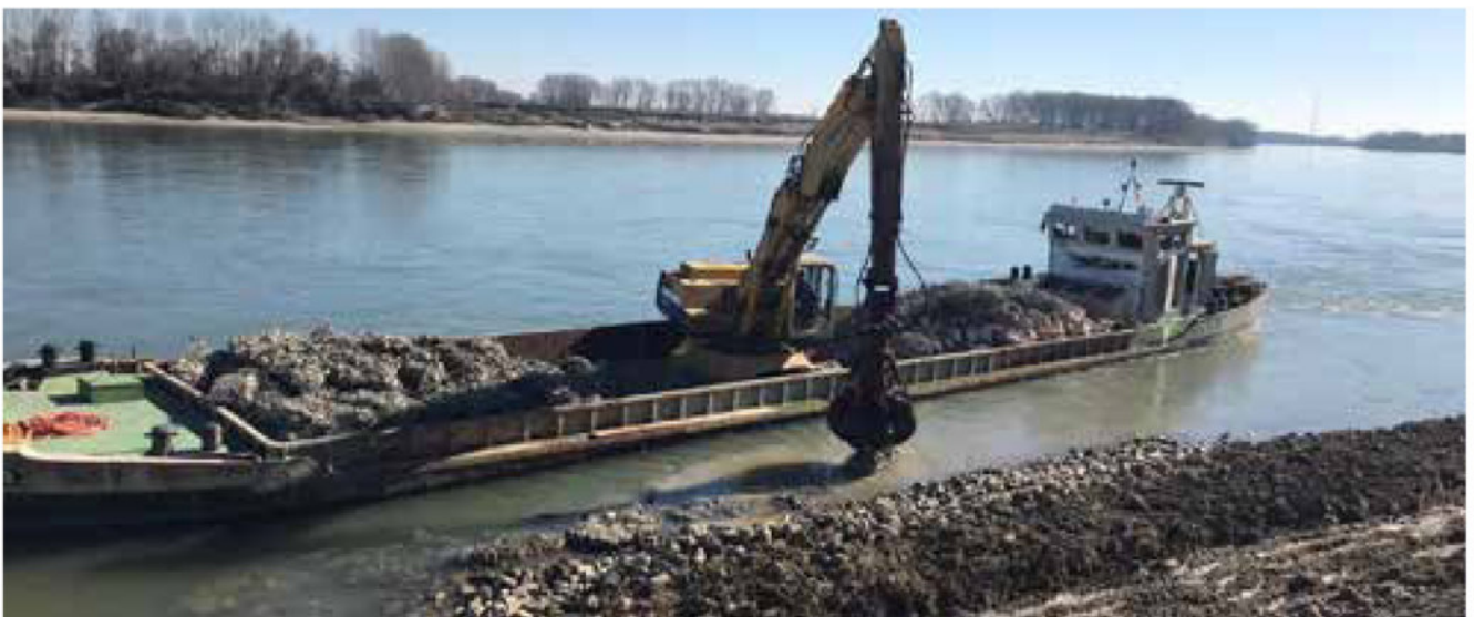
Posa di burghe da barcone - Fiume PO Torre d'Oglio
